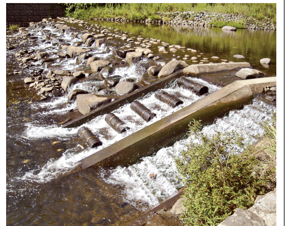
長崎県西海市・雪浦川に設置されたエコステップ魚道。片側には透過性パイプも付設
