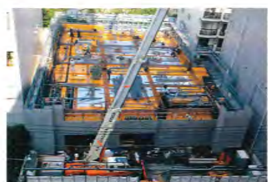
[10月30日] 2階部分の工事
