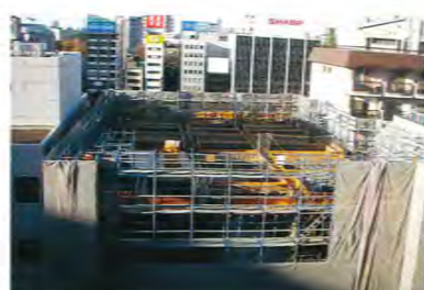
[12月20日] 3階から4階部分への工事
