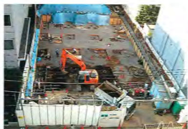
[8月27日] 掘削工事
