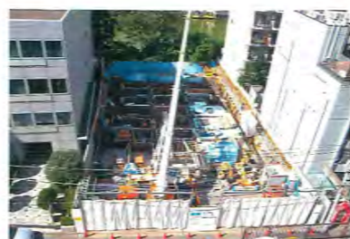
[9月24日] 1階部分の工事
