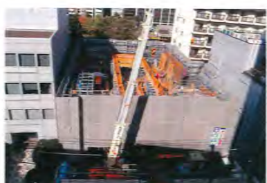
[11月20日] 3階部分の工事
