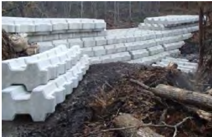
コンクリートブロックによる仮設えん堤 (H26御嶽山)
