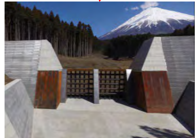
土砂をコントロールするための砂防堰堤の整備
