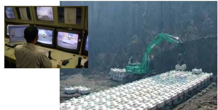
無人化施工によるブロック積み (H12三宅島)
