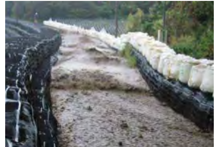
大型土のうによる仮設導流堤 (H12三宅島)
